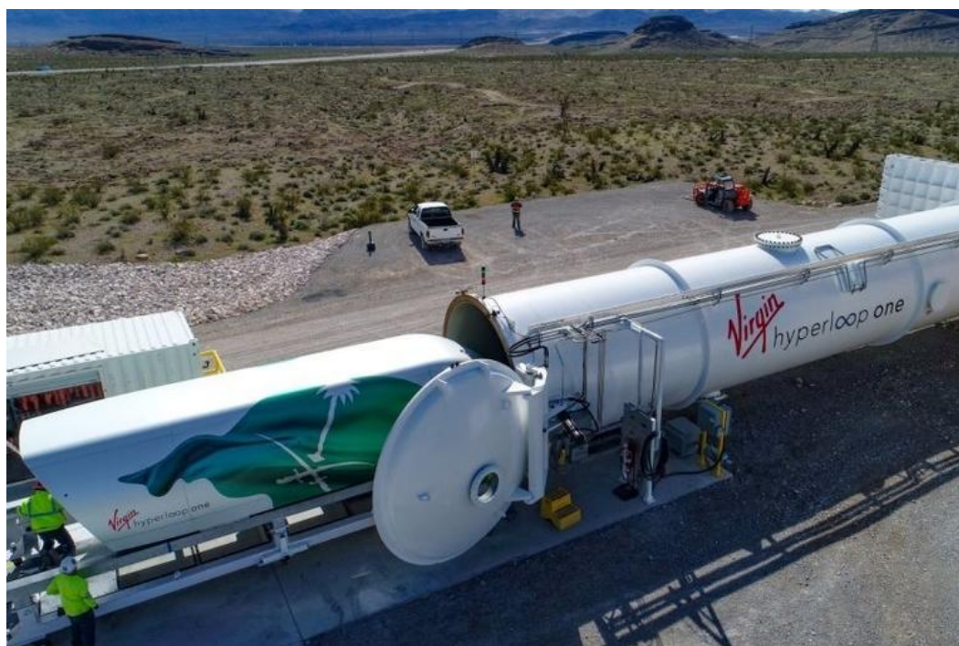
Testbane i Saudi-Arabien, byggeri af en 35 km lang testrute.
